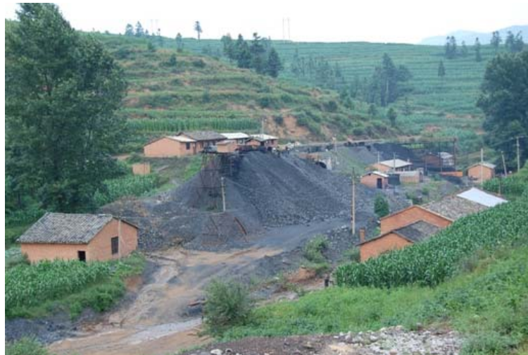
图 3.1 高卷槽煤矿地面生产区照片
